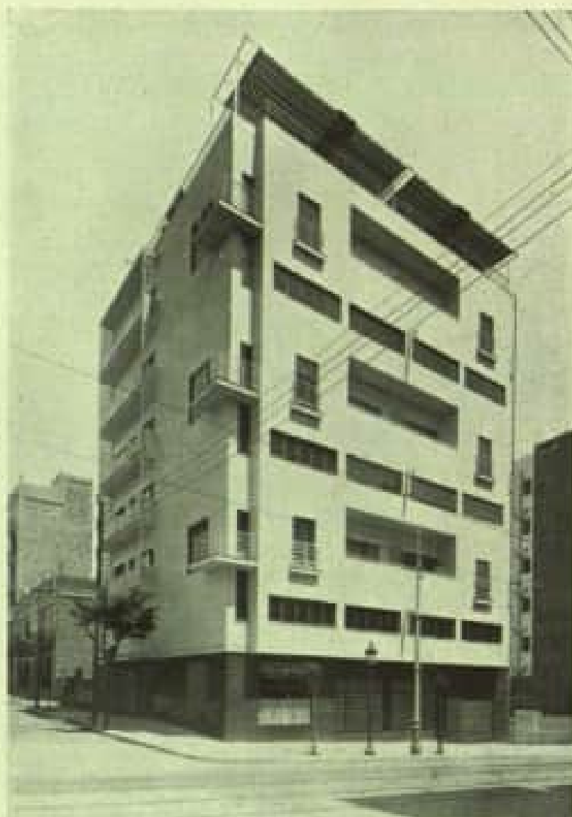
Casa al carrer de Montaner, projectada per l'arquitecte Josep Llinís Sert.
